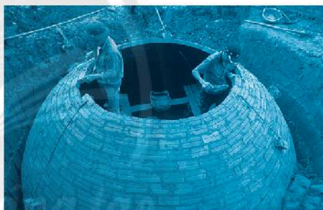
Xây hầm ủ chất thải gia súc để lấy biogas
